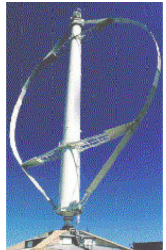
3 MW Darrieus-type windturbine bij Cap-Chat, Canada
