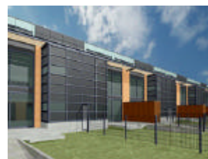
Paneelverdeling (boven, bewerking door Polder PV) en artist impression © HAN VAN ZWIETEN ARCHITECTEN BNA, Zeist (van website http://www.kopersverenigingroomburg.info/welkom.htm , onder) van de energiezuinige woningen in Roomburg met o.a. een vliesgevel met amorfe zonnepanelen.
